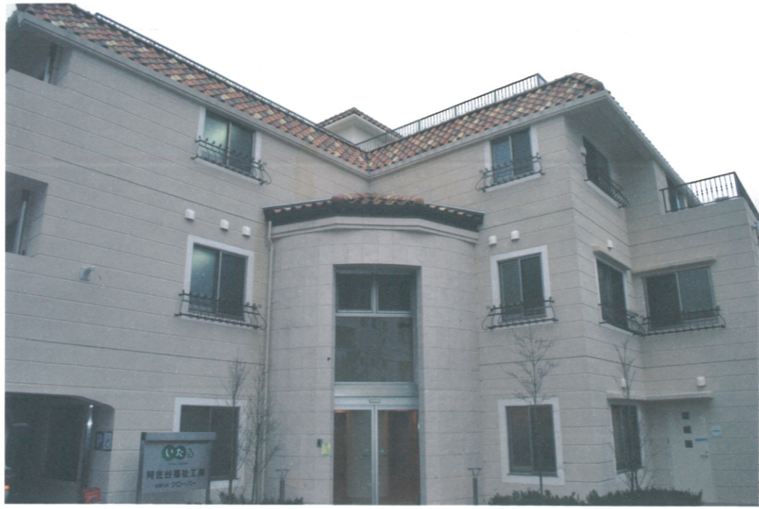
新屋舎完成！震度7に耐えられる建物です。50年先の未来を見据えています。
