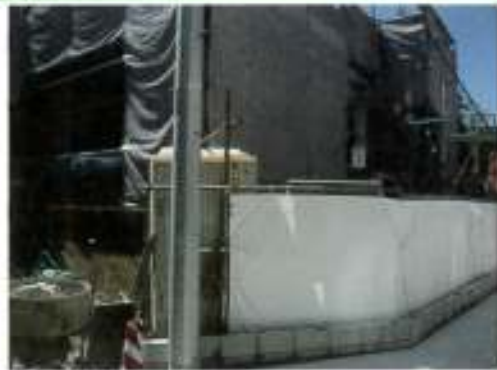
完成間近の新ワルツの様子
