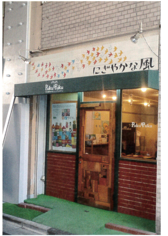
高架下の補強工事を終えた店舗の外装
