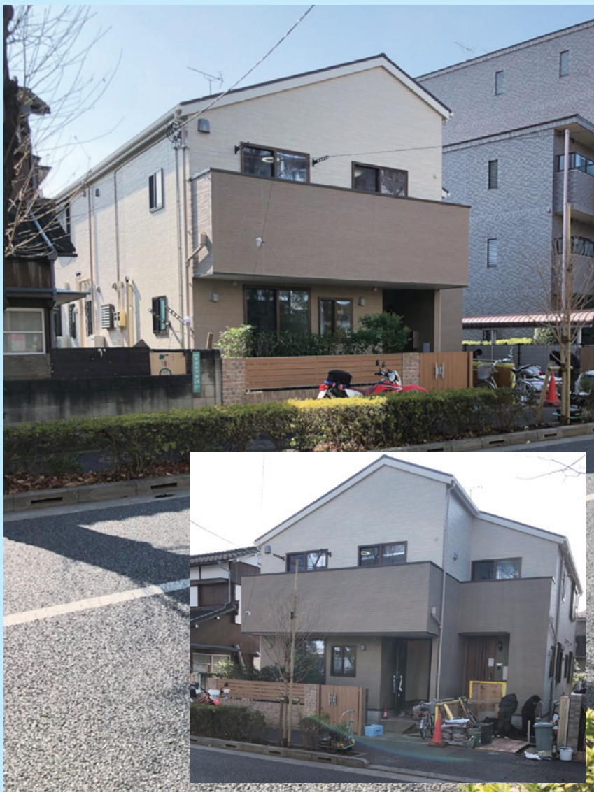
耐震性のある木造住宅を全面改修した2階建ての建物が、5名のご利用者様の生活拠点に
